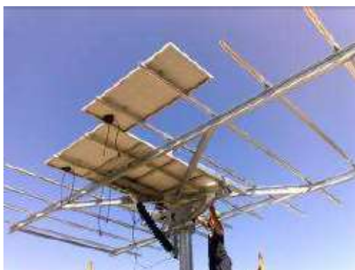
FIGURA 93. ATAȘAREA MODULELOR PV DE STRUCTURĂ. (Sursa: EKILOR)
