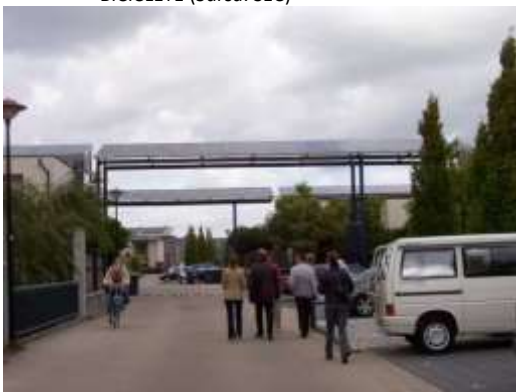
FIGURA 82. ZONA REZIDENȚIALĂ AMERSFOORT, BIPV PE ACOPERIȘURILE PARCĂRIILOR DE MAȘINI ȘI BICICLETE (Sursa: SEC)
