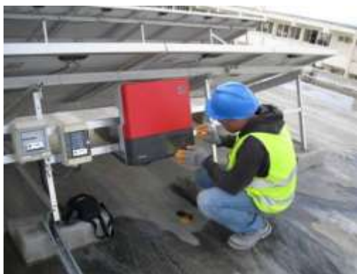
FIGURA 156. INSPECȚIA INVERTOARELOR DIN SISTEME PE ACOPERIȘ, CONECTATE LA REȚEA, CIPRU. (Sursa: Conercon Ltd)
