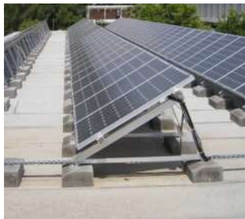
FIGURA 148. VEDERE LATERALĂ A STRUCTURII SUPORT (Sursa: ETEK)
