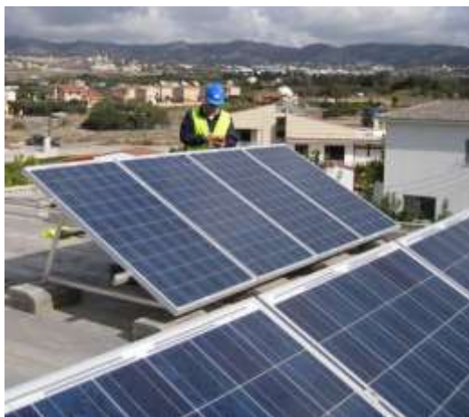
FIGURA 154. INSPECȚIA PERIODICĂ A ANSAMBLULUI PV A UNUI SISTEM MONTAT PE ACOPERIȘ ȘI RACORDAT LA REȚEA, CIPRU. (Sursa: Conercon Ltd, Cyprus)
