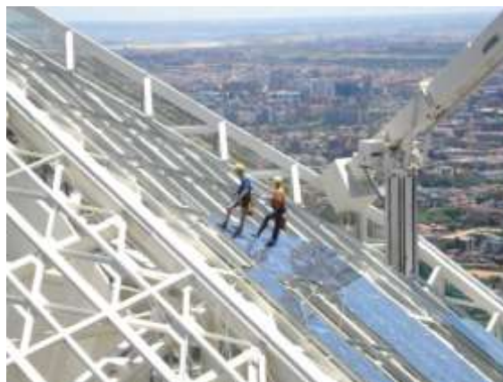
FIGURA 87. LUCRU LA ÎNĂLȚIME pe Cristal Tower (Sursa Martifer Solar SA.)
