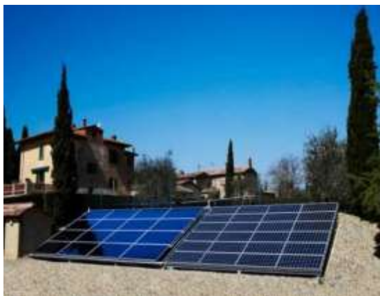
FIGURA 12. UMBRIRE DATORATĂ OBSTACOLELOR DIN VECINĂTATE (Sursa: Energia e Domotica, Flickr, 2011)
