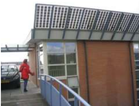
FIGURA 50. BAPV PE ACOPERIȘ ÎNCLINAT. (Sursa: SEC )
