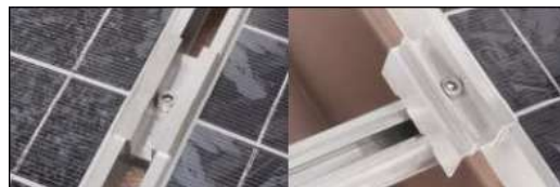
FIGURA 151. PRINDEREA UNUI MODUL DE ȘINĂ (Sursa: SOLVIS)
