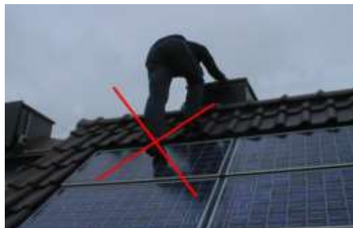
FIGURA 116. NU PĂȘIȚI PE MODULELE PV (Sursa: ECN)
