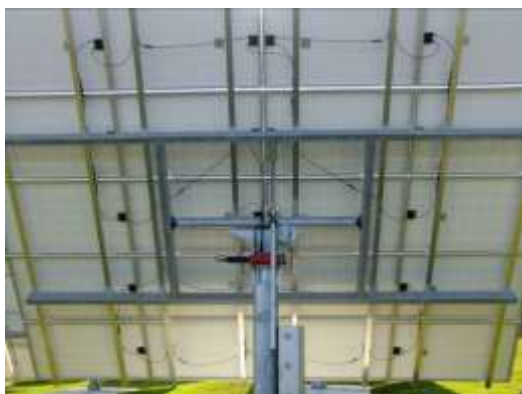
FIGURA 152. CONEXIUNEA ELECTRICĂ A MODULELOR – PARTEA DIN SPATE
