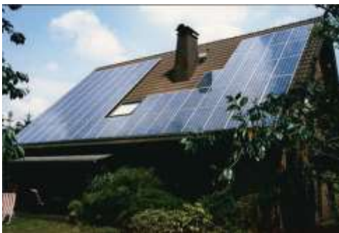
FIGURA 50. BAPV PE ACOPERIȘ ÎNCLINAT. (Sursa: SEC )
