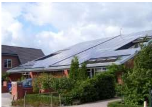
FIGURA 56. BIPV PE CLĂDIRE REZIDENȚIALĂ (Sursa: SEC)
