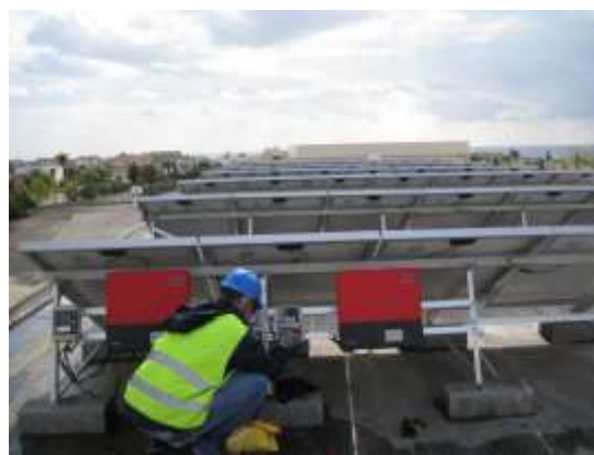
FIGURA 158. ÎNTREȚINEREA CONEXIUNILOR ELECTRICE. (Sursa: Conercon Ltd)
