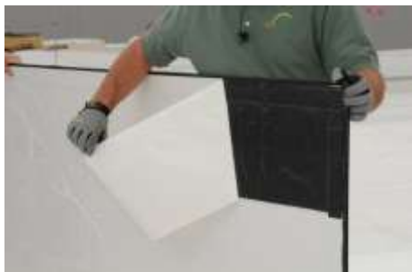
FIGURA 122. SECVENȚA DE INSTALARE A PANOURILOR AUTO ADEZIVE (Sursa: Lumeta Inc)
