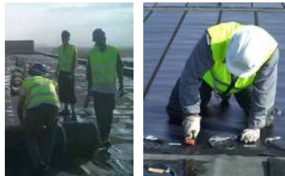
FIGURA 121. INSTALAREA DE PANOURI FLEXIBILE (Sursa: Biohause)
